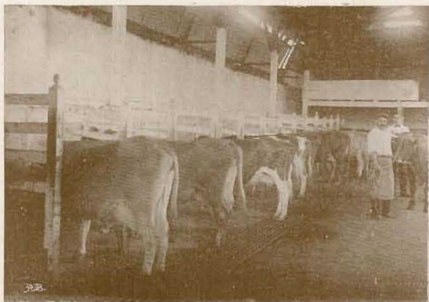
INTERIOR DE LA LECHERÍA - INTERIOR DAIRY
