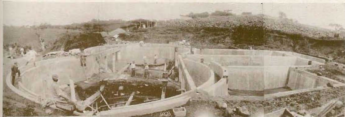
VISTA GENERAL DEL TANQUE DE PURIFICACIÓN DEL AFLUENTE DE LAS CLOACAS—CONSTRUCCIÓN—GENERAL VIEW SEWAGE DISPOSAL WORKS
