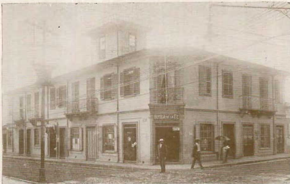
EDIFICIO COMERCIAL PROPIEDAD DE LOS SRES. HIJOS AGUSTIN ATMETLLA Y ORONI
