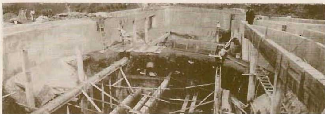
VISTA GENERAL DEL TANQUE DE PURIFICACIÓN DEL AFLUENTE DE LAS CLOACAS (CONSTRUCCIÓN) GENERAL VIEW SEWAGE DISPOSAL WORKS (CONSTRUCTION)
