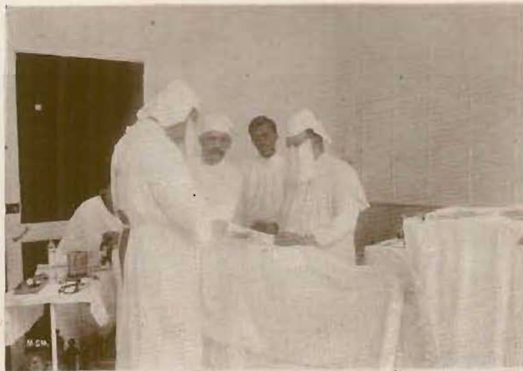
Sala de operaciones - CASA SALUD - Operating Room
