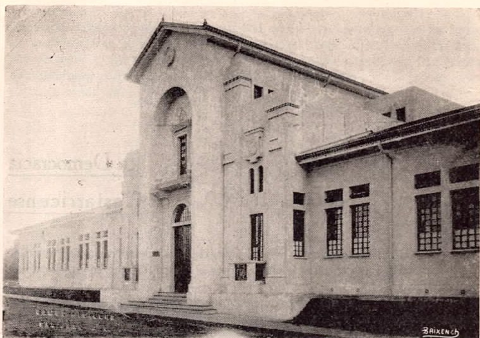
Frente del moderno edificio de cemento armado que ocupa la Escuela República de Chile, en San José. Está construido con todas las posibles comodidades y dispone, además, de amplio espacio para ejercicios físicos de los alumnos.
