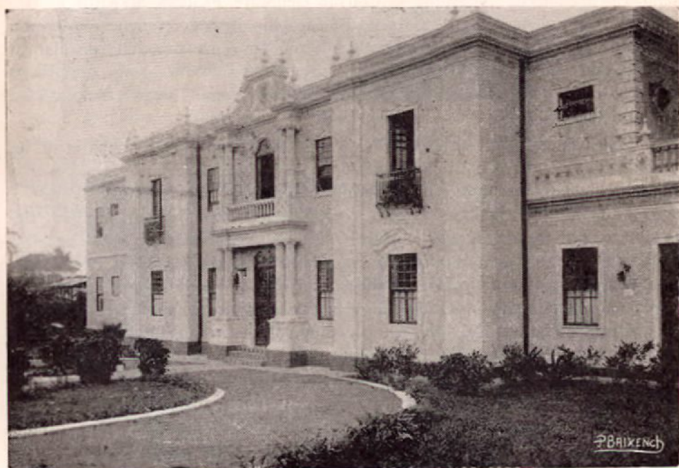
Solamente dos de las Naciones tienen edificio propio para su representación Diplomática en Costa Rica. La Legación Americana y la Legación de México, que aquí se reproduce. Es una de las construcciones más lujosas, sobre todo en su interior, donde se ha utilizado material mexicano de refinado gusto y extraordinario lujo.
