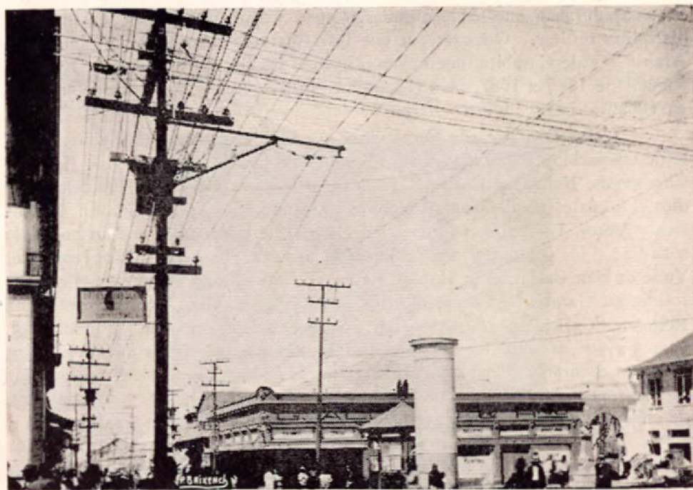
En una de las plazoletas centrales de la capital existía esta instalación de líneas, postes y "torres" para transformadores. Se trata aquí de la esquina del Banco de Costa Rica, que ha sido modernizada por las Compañías de Electricidad, conforme puede observarse en el grabado de la página 410.
