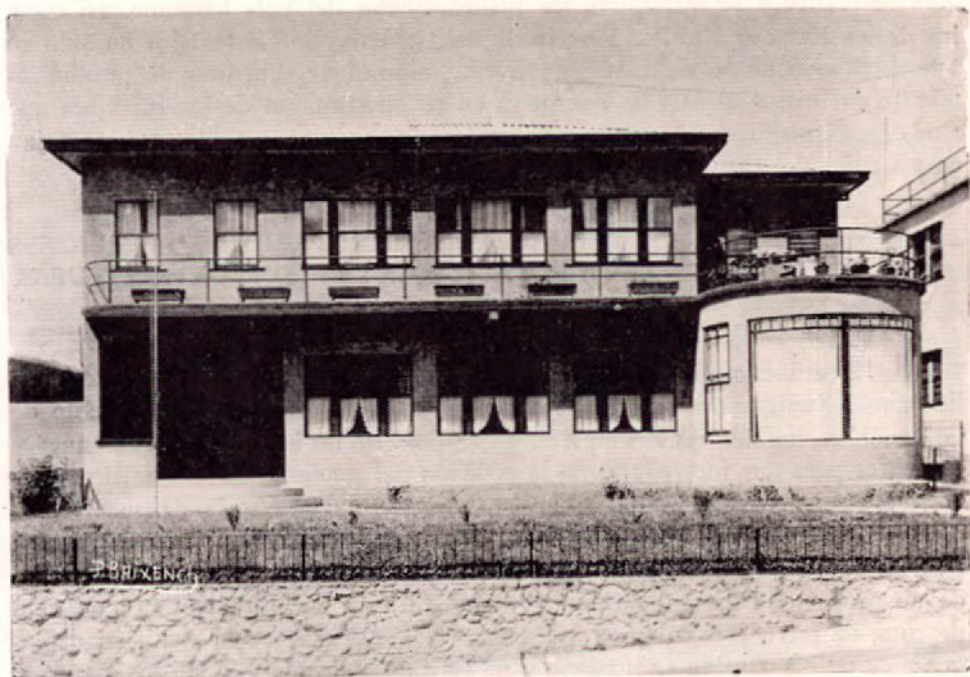
Una preciosa Villa construida en San José por la Empresa "El Ingenio", del Ingeniero don Francisco Jiménez Ortiz.
