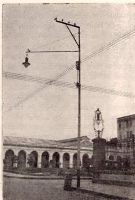
Antes de haberse establecido en San José el sistema moderno de distribución de las líneas trasmisoras de la corriente que proporcionan las Compañías de Electricidad, era frecuente encontrar postes a bastante distancia fuera de las aceras, casi en mitad de la calle, como puede observarse en el grabado de la izquierda. Ambos grabados corresponden a la misma esquina del Teatro Nacional.
