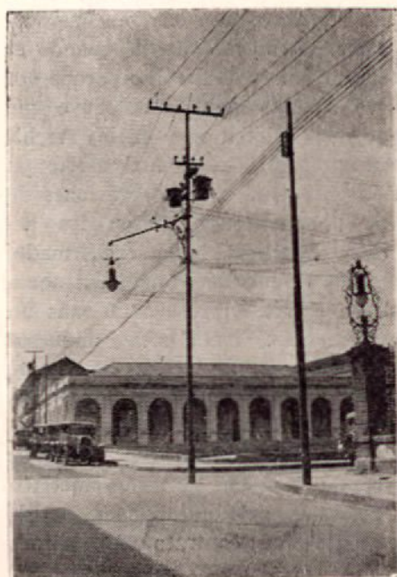
Antes de haberse establecido en San José el sistema moderno de distribución de las líneas trasmisoras de la corriente que proporcionan las Compañías de Electricidad, era frecuente encontrar postes a bastante distancia fuera de las aceras, casi en mitad de la calle, como puede observarse en el grabado de la izquierda. Ambos grabados corresponden a la misma esquina del Teatro Nacional.
