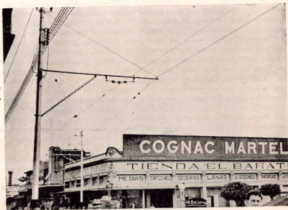
Actualmente la distribución eléctrica en la esquina del Banco de Costa Rica está modernizada por las Compañías de San José, siguiendo el plan adoptado para toda la ciudad. Puede observarse la diferencia comparando éste con el grabado de la página 402.
