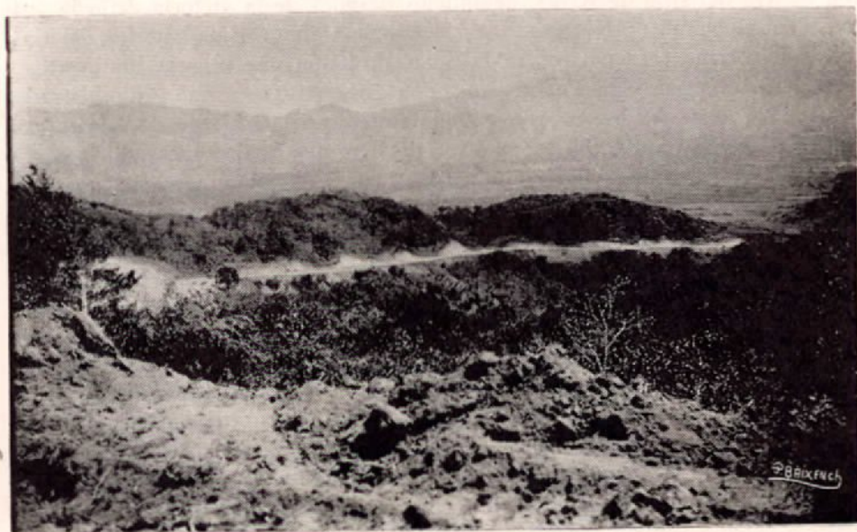
Vista panorámica de un trecho de carretera terminado. Sección Cartago-San Marcos
