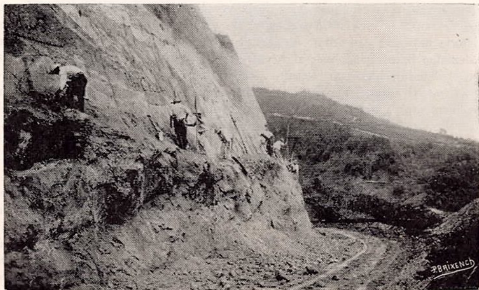
Cuadrilla puliendo uno de los cortes en la Sección Cartago-San Marcos.
