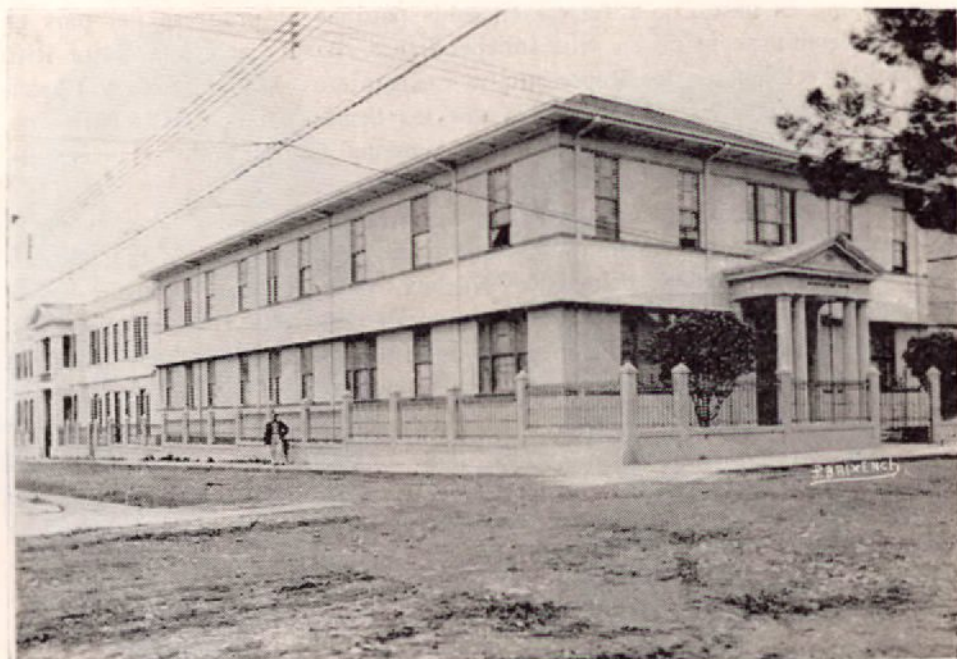
Edificio de la Clínica Bíblica, que presta excelentes servicios en la Capital y pertenece, como su nombre lo indica, a una organización que tiene ramificaciones en todo el mundo.
