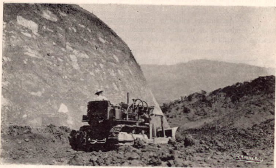
Tractor terminando un corte.—Sección Cartago-San Marcos.
