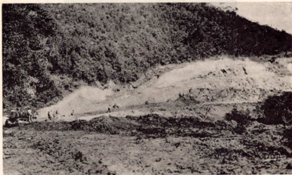
Cuadrillas puliendo un corte y tractor terminando un relleno.—Sección Cartago-S. Marcos.
