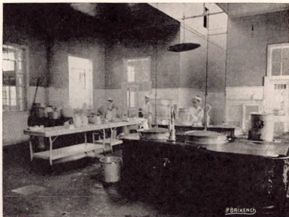
Hace algunos años la cocina del Hospital despedía un olor singular, penetrante y muy desagradable. En la actualidad nada de eso se observa pues la cocina es eléctrica y está montada con esmero en cuanto a amplitud y aseo. La comida que se sirve a los enfermos es suficiente y bastante buena. además. Los casos especiales reciben alimentación de acuerdo con las prescripciones médicas.
