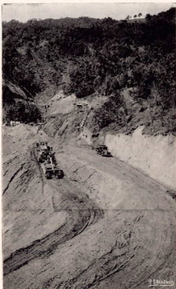
Tractor con trilla haciendo un relleno grande. Sección Cartago-San Marcos.
