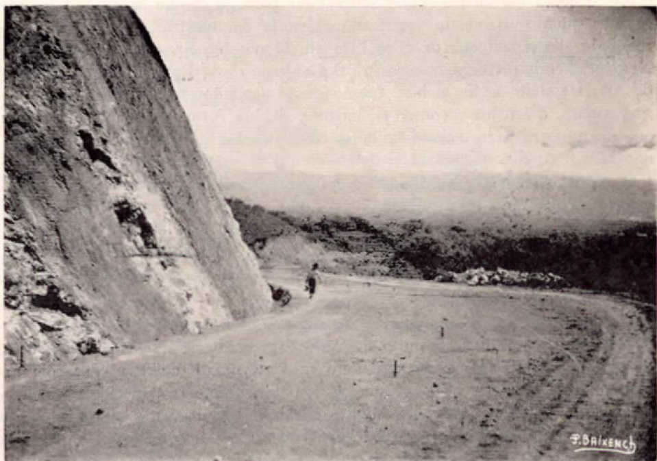
Vista de un corte y subsuelo, ya terminados. Sección Cartago-San Marcos.
