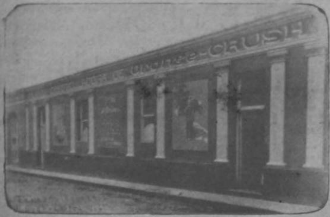
Fachada de la Planta
