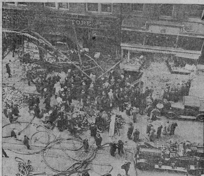
La explosión de una caldera causó grandes daños en un almacén de Washington, matando cinco personas e hiriendo a más de cincuenta
