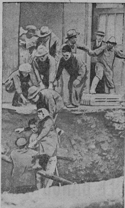
Una sección de la calle 14 en la esquina de la avenida octava de Nueva York se hundió a causa de las excavaciones para un ramal de ferrocarril subterráneo. La foto muestra los trabajos de salvamento de algunas personas que cayeron al producirse el hundimiento
