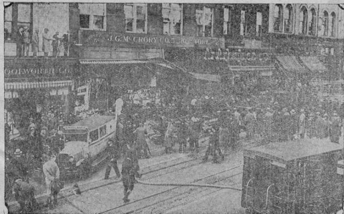
La foto muestra la tienda de 5 y 10 centavos Mc Crory, en Washington, parcialmente destruida por la explosión de una caldera
