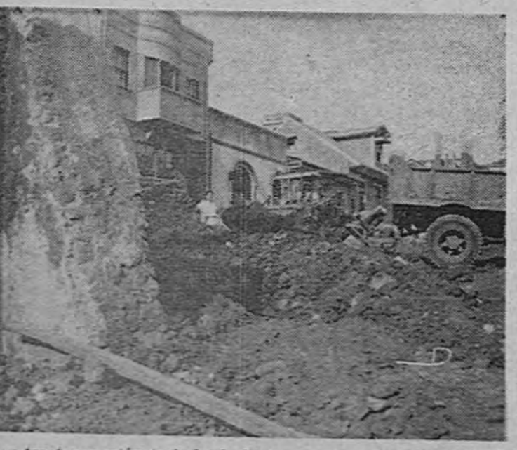
Los tractores están trabajando intensamente para remover la tierra que servía de relleno a Cuesta de Moras. Esa tierra está siendo trasladada a otras partes
