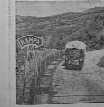
En los tramos de carreteras con fuertes pendientes, se han construido rampas de seguridad para que los automovilistas que por cualquier circunstancia han perdido el control de la velocidad, puedan detenerse sin otros vehículos.
