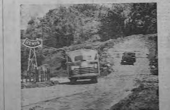
El letrero indica dónde está la rampa. Se puede ver un vehículo que ha entrado en el desvío, deteniéndose por acción del plano inclinado.
