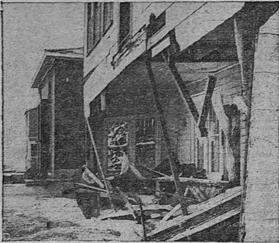
EL HURACAN DORA, — lanzó el Océano Atlántico contra esta casa de la costa en Jacksonville Beach, Florida, tan fuertemente que arrancó una pared.
