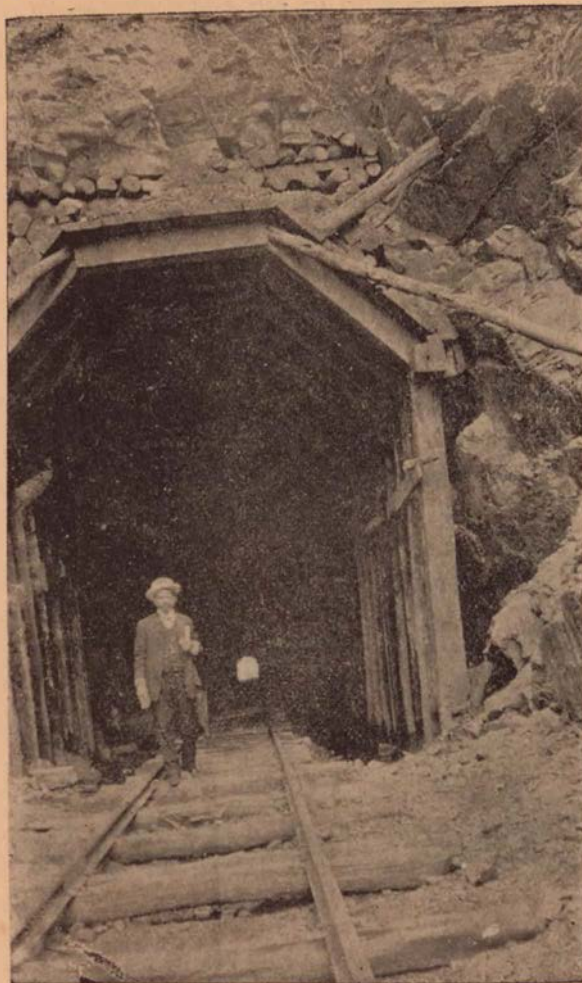
Un túnel en la sección próxima á inaugurarse
