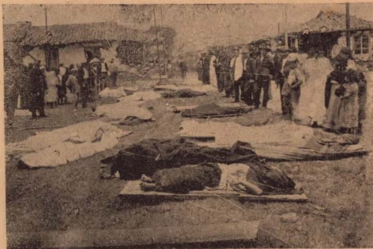
Los muertos en la calle, aguardando las ambulancias. Sus feretros fueron apenas tablas recogidas de los mismos escombros.
