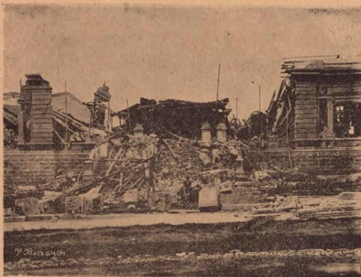
Edificio de la Corte Centroamericana de Justicia, construido con un donativo de $ 100.000-00 de Mr. Andrew Carnegie, de los Estados Unidos. Estaba próximo á inaugurarse cuando fué destruido
