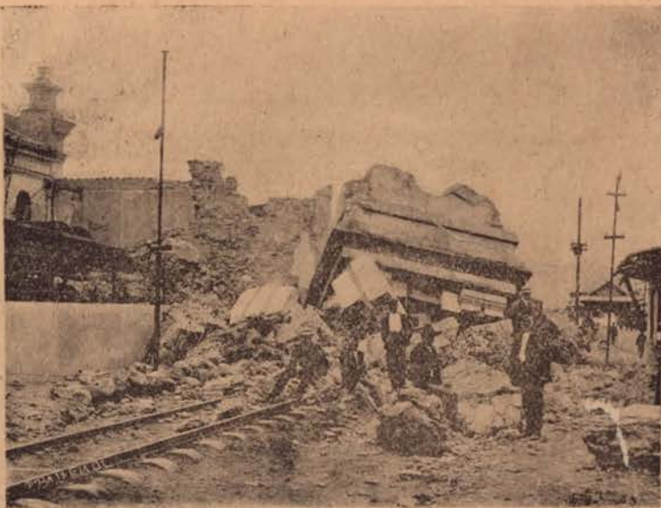
Las pesadas torres, de la Iglesia del Carmen, dieron vueltas en el aire y al caer sobre la línea férrea la hundieron un metro.
