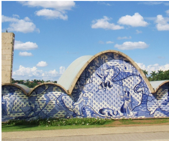
Figure 3.c.11: Portinari. Igreja de São Francisco de Assis. Complexo da Pampulha, BH-Minas Gerais.1948. Available at the site Projeto Portinari. Ceramic.
