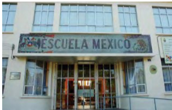
Figura 3.b.08: Vestíbulo de la Escuela México, Chillán, Chile (foto circa 2014).
