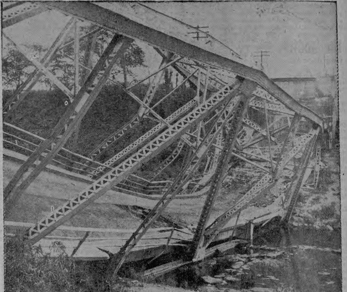
Un aspecto impresionante del gigantesco puente de hierro sobre el río Sagua La Chica, camino a Santiago de Cuba, en Falcón, derribado por los rebeldes para impedir el paso de los tanques de Batista hacia Placetas que había sido tomada por el "Ché" Guevara. (Foto periódico Avance).
