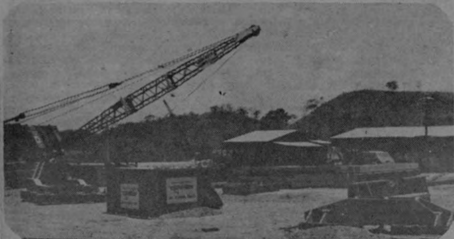
La grúa acomoda la gran cantidad de materiales de construcción que se emplean en la construcción de la infraestructura de la planta de Cementos del Pacífico S.A. (subsidiaria de CODESA).
