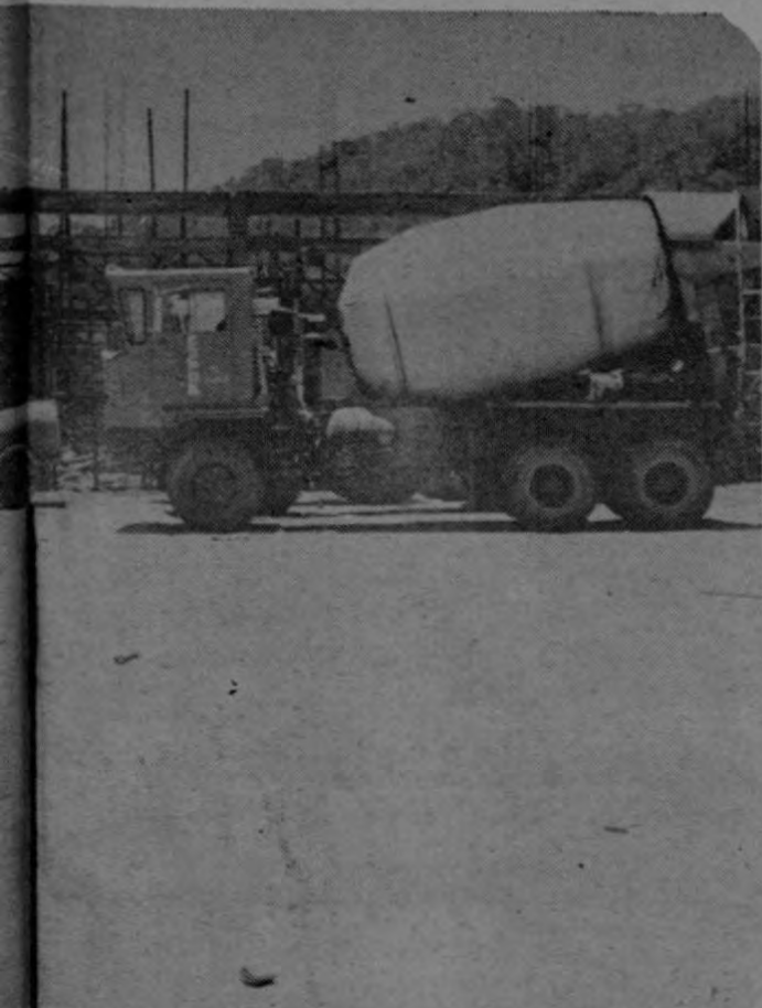
de concreto, vagonetas y otros tipos necesariamente con el fin de tener la planta en 1979 o inicios de 1980.
