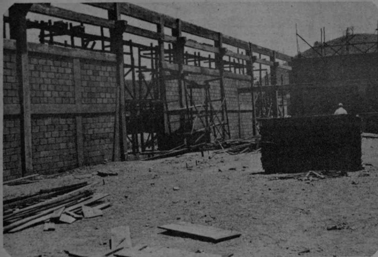
Las paredes del almacén, y talleres ya están concluidas y en los próximos días se colocarán las cerchas del armado del techo. El trabajo de compactación de los pisos de los edificios se encuentra asimismo terminado.
