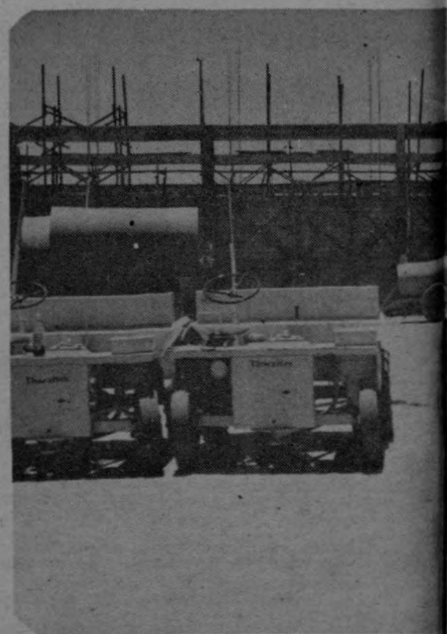
Camiones, grúas, batidoras y de maquinaria trabajan en la planta en operación a fines
