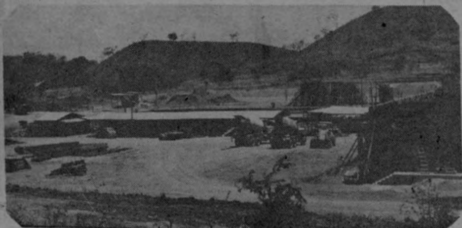
Al frente del plantel de la empresa constructora y al fondo la estructura de la sección de control del horno.
