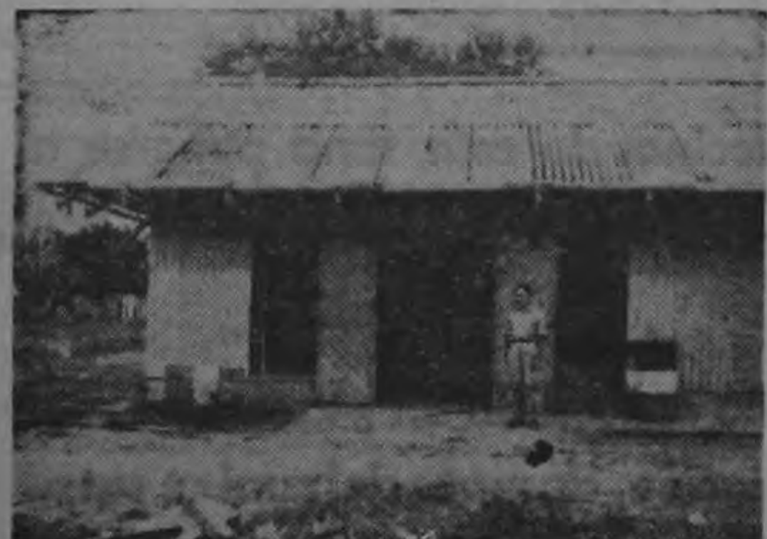
Casa de máquinas en que están las unidades eléctricas Diesel que tiene la Municipalidad de Puerto Cortés. Puede apreciarse al operador de las mismas
