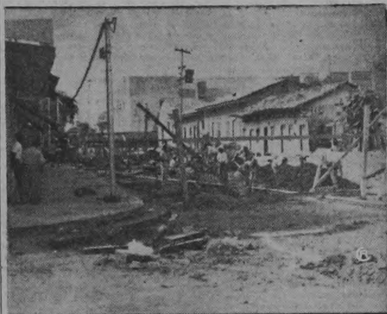
Puede apreciarse en esta gráfica la forma en que han quedado las calles y aceras recién terminadas en Puntarenas. Además de la construcción de aceras y caños, se ha reforestado convenientemente las calles.
