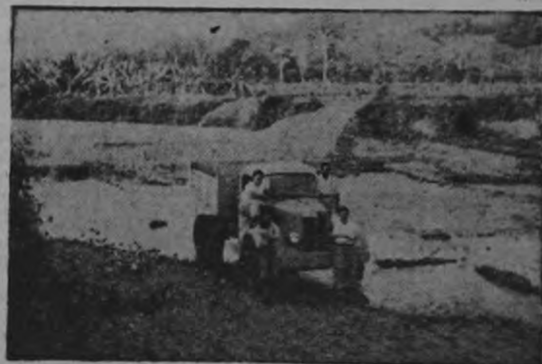
Elementos de la municipalidad de Puerto Cortés en compañía de nuestro Redactor, en el río Balsar, que suministra toda la piedra necesaria para los trabajos municipales
