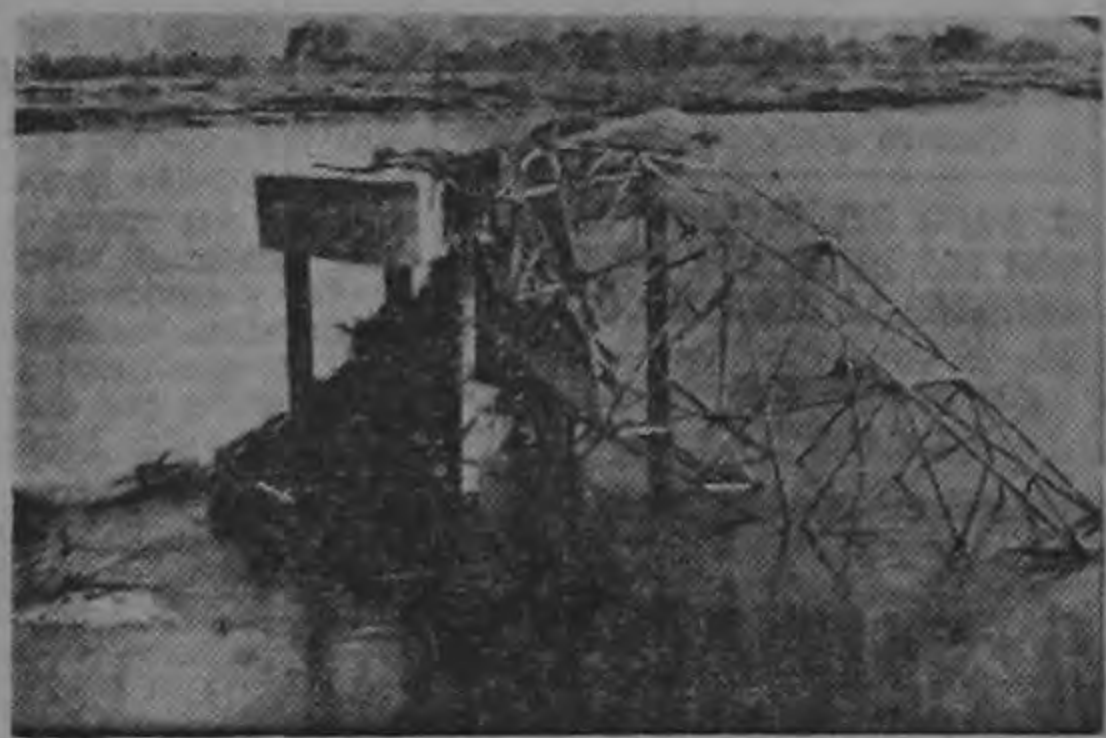
Plataforma de acero y concreto donde estuvieron las torres del andarivel que en otro tiempo transportó bananos y personas. Esta plataforma será la que utilice la municipalidad para el nuevo muelle.
