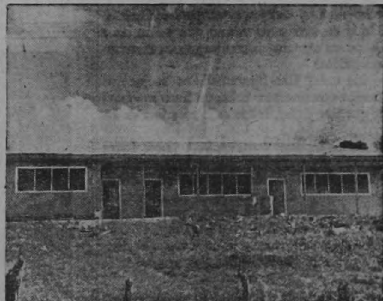
Escuela construida en Administración Figueres. Esta escuela está en el distrito de El Alto, jurisdicción de Golfito.
