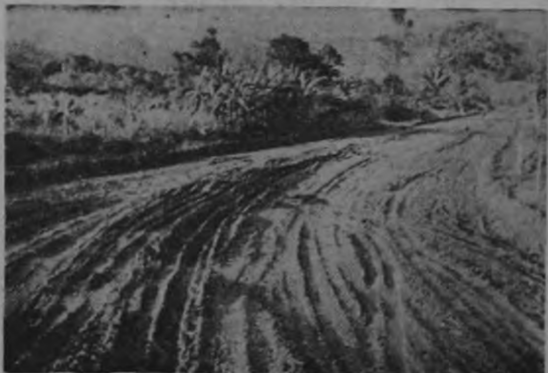
Vista parcial de la carretera que se está construyendo de Puerto Cortés a Palmar Norte
