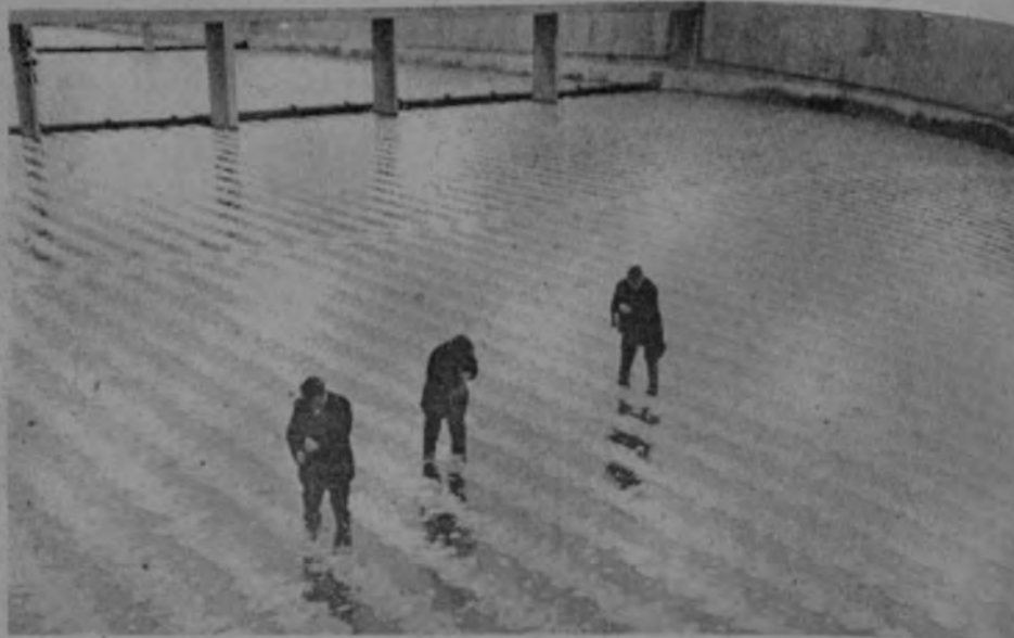
En los grandes países como la Gran Bretaña existen sofisticadas instalaciones para la purificación de aguas negras. En la fotografía se observan tanques de aireación que contribuyen a tal fin.
